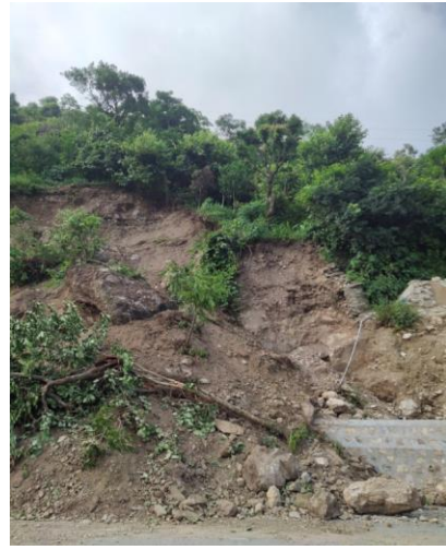
(d) Fakot 2 landslide
